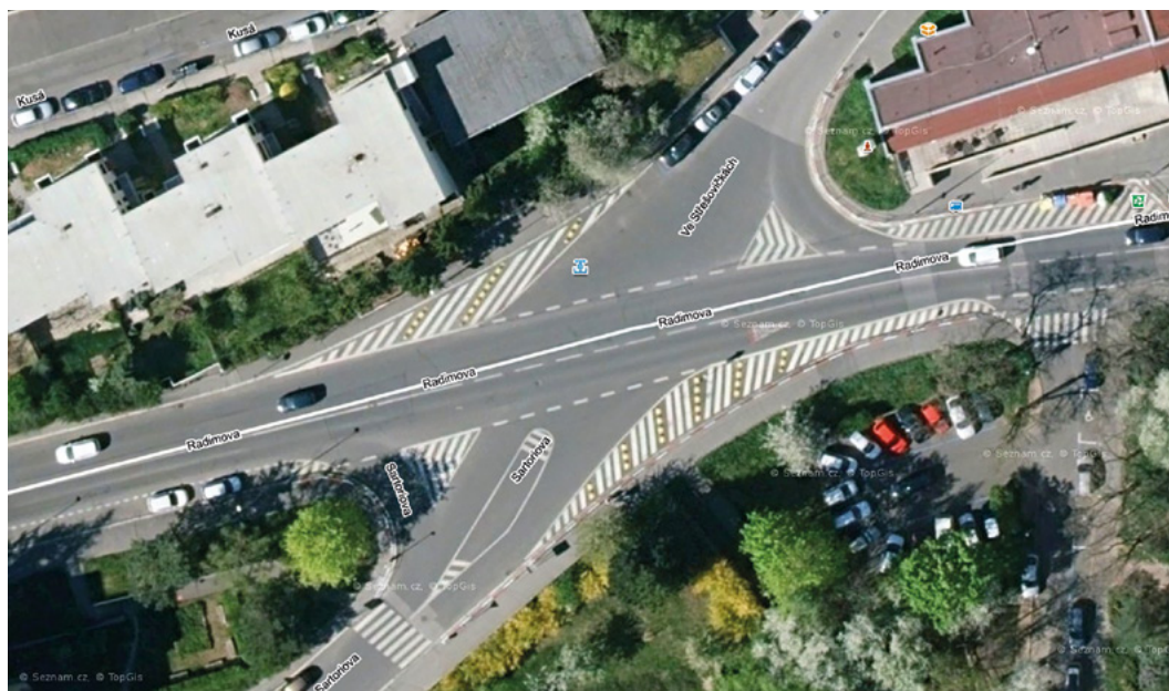
Obr. 13.4 Křižovatka Radimova – Ve Střešovičkách v Praze 6 – nevyhovující úhel křížení [344]
