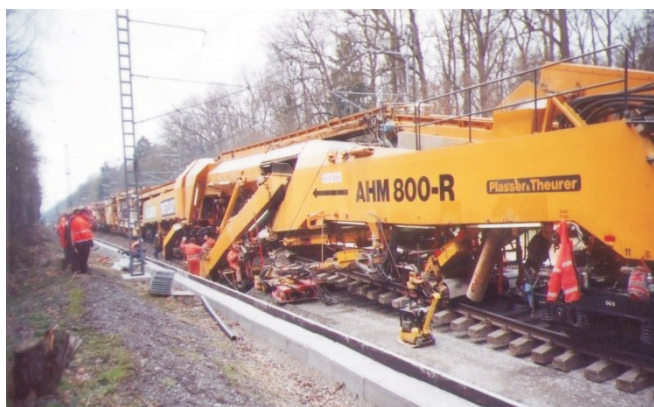
obr. 5.1 Sanace železničního spodku bez snášení kolejového roštu strojem AHM800 (traťový úsek Tlumačov-Hulín, 09/2000)
