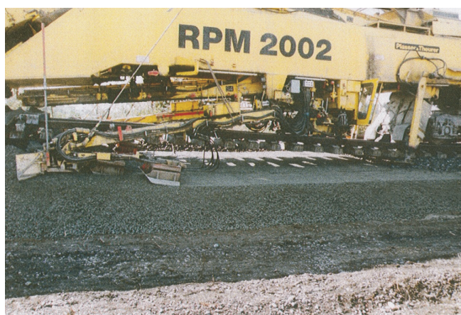
obr. 5.2 Sanace železničního spodku bez snášení kolejového roštu strojem RPM2002 (traťový úsek Grygov – Brodek u Přerova, 09/2005) (foto P. Vitek)
