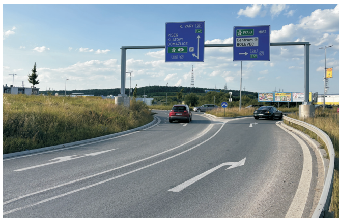
obr. 3 Ukázka dopravního značení na okružním pásu 6ramenné turbokružní křižovatky v Plzni
