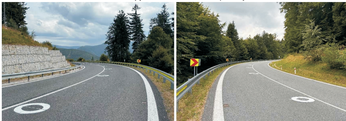
obr. 3 Vodorovné dopravní značení ve směrových obloucích pro motocyklisty
