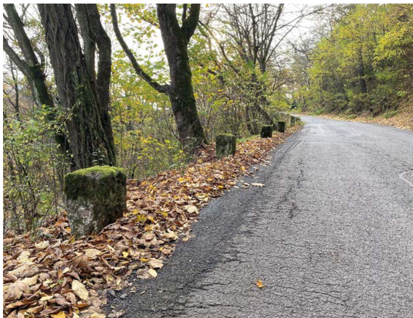
Obrázek 1: Zejména v horských oblastech lze stále nacházet liniové vymezení komunikace vodícími patníky, které připomínají minulost a dotvářejí estetiku současnosti (na snímku silnice č. III/10134 vedoucí podél obory Podkozí).
